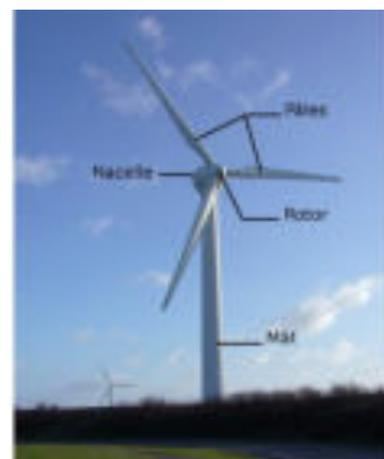
Figure 53 : Schéma d'une éolienne
